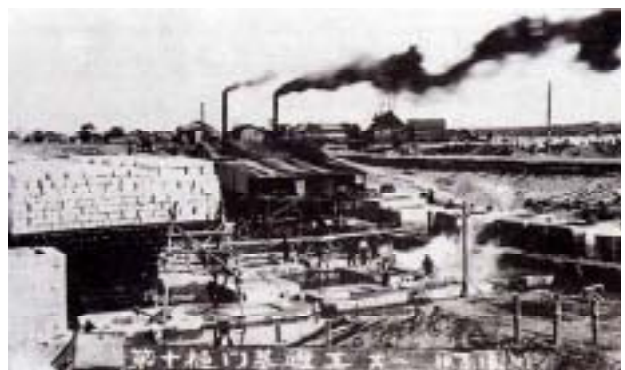
第十樋門の基礎工事の様子
