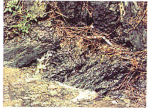
■平成5年洪水による「法尻の漏水」 (石井町西覚円/河口より18km付近)
