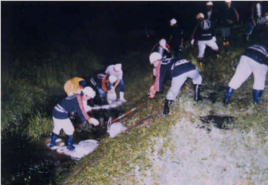
月の輪作業状況左岸17.2～18.6k (H11.7台風5号)
