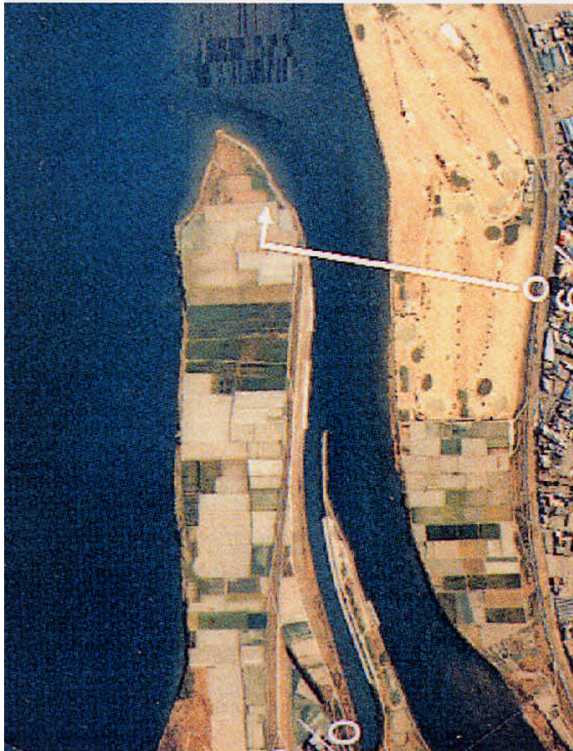
導流堤（徳島県の吉野川） 河川が他の河川に注ぐ場合、流路を一定にさせるために流水を誘導する目的で設ける。
