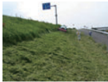
除草作業の状況写真
