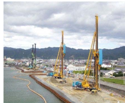
堤防液化化対策【旧吉野川(徳長地先)】
