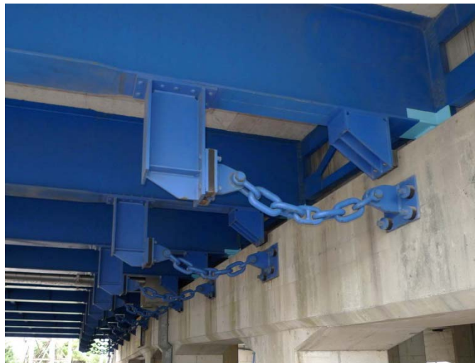
現在の耐震補強状況
