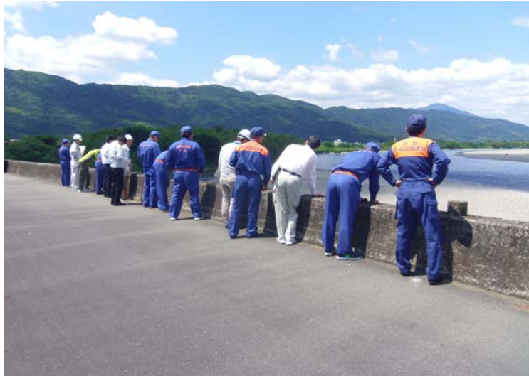
2016/6/2 吉野川川島箇所(漏水)における巡視
