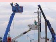
配電線復旧訓練
