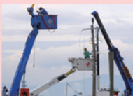
配電線復旧訓練
