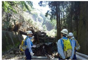
法面崩壊発生箇所の調査(南阿蘇村)
