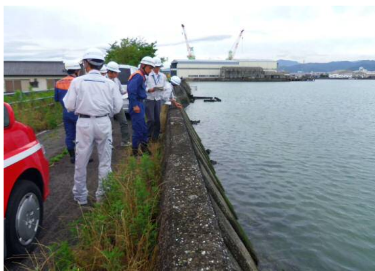
2015/6/9 今切川右岸箇所(堤防高不足、洗掘等)における巡視
