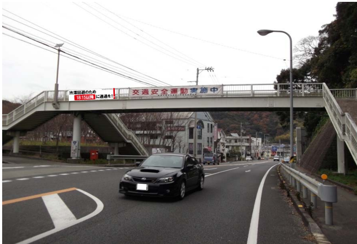
国道55号大浦横断歩道橋（北行）への横断幕設置イメージ
