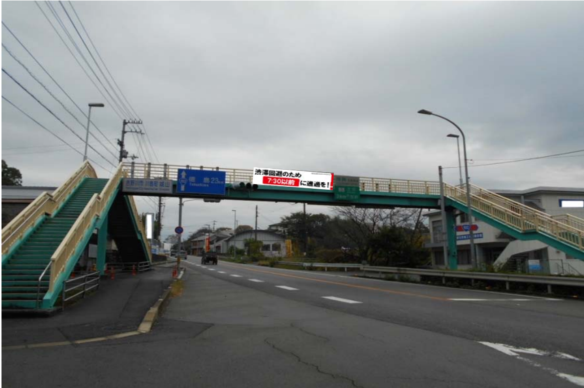
国道192号川島横断歩道橋（東行）への横断幕設置イメージ
