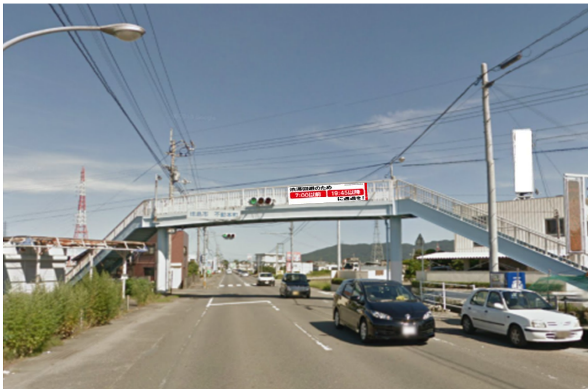
(主) 徳島引田線不動町歩道橋（南行）への横断幕設置イメージ
