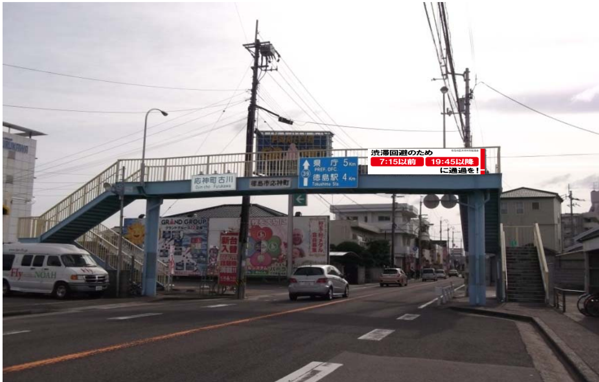
(主) 徳島鳴門線応神歩道橋（南行）への横断幕設置イメージ
