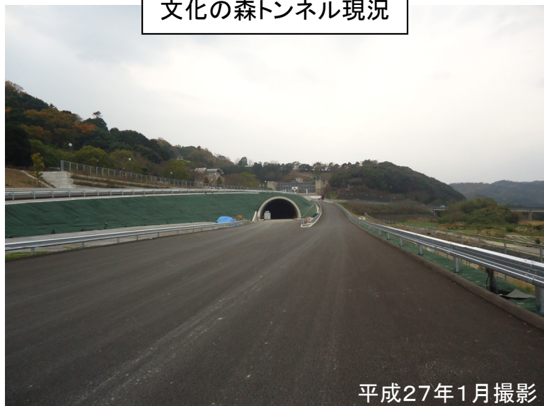
文化の森トンネル現況
