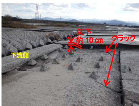
コンクリート版の損傷状況
