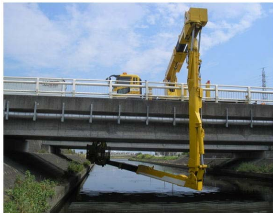
■ 高所作業車による点検
