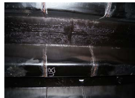
【箱桁内部の亀裂(当て板補修)】
