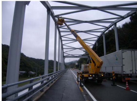
■ 高所作業車による点検
