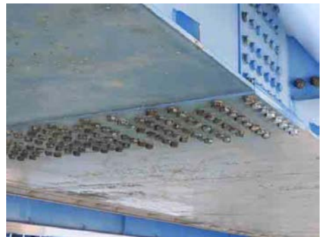
【箱桁内部の亀裂(当て板補修)】
