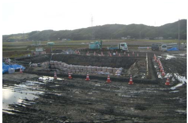
中ノ坪川橋下部工事(平成26年10月現在)
