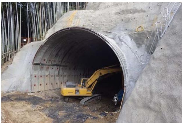
平成24-26年度 田野トンネル工事(平成26年10月現在)
