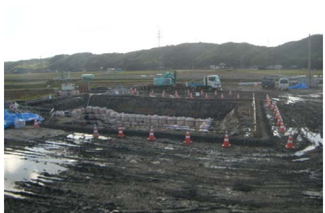
中ノ坪川橋下部工事(平成26年10月現在)
