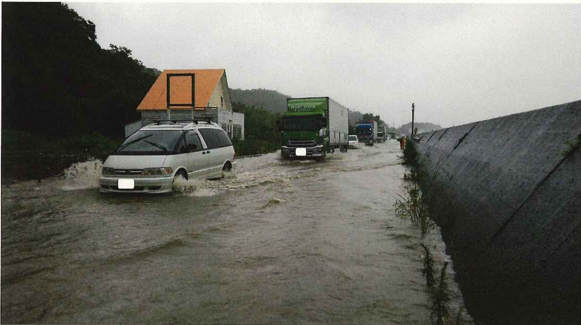
国道11号 鳴門市北灘町 路面冠水状況 (8月9日 9:00時点)
