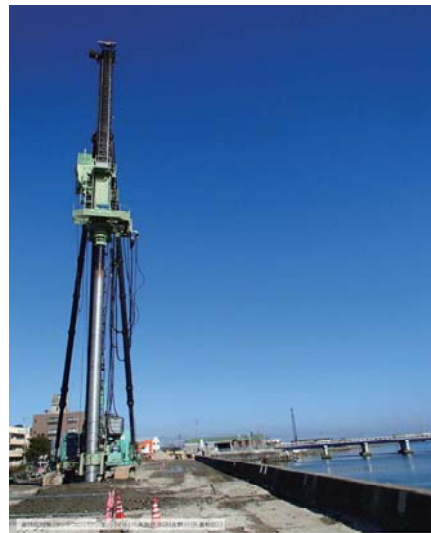
展示用パネル例（地震対策工事）
