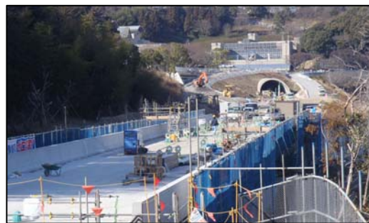
②文化の森 IC(仮称)付近整備状況 (撮影日:平成 26 年 1 月)
