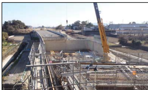
③法花 IC (仮称) 付近整備状況 (撮影日:平成 26 年 1 月)
