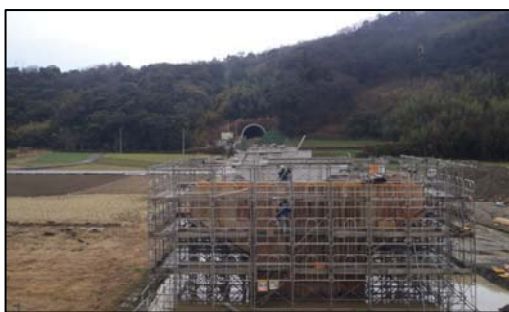
①大木 IC(仮称)付近整備状況 (撮影日:平成 26 年 3 月)
