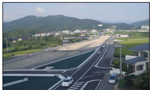
④平成 24 年度開通区間交通状況
