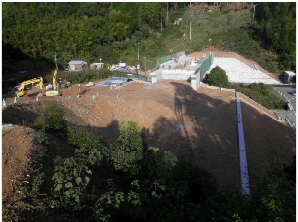
【天王谷地区】 盛土工施工状況
