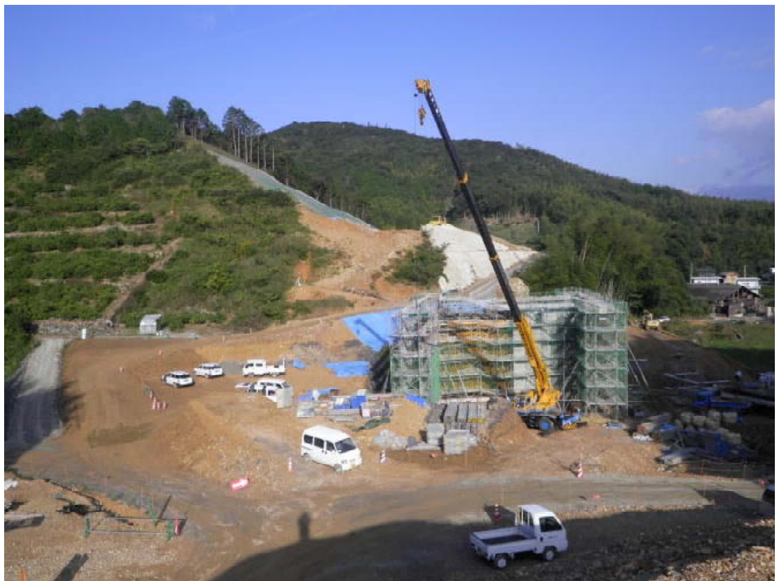
【天王谷地区】 函渠工施工状況
