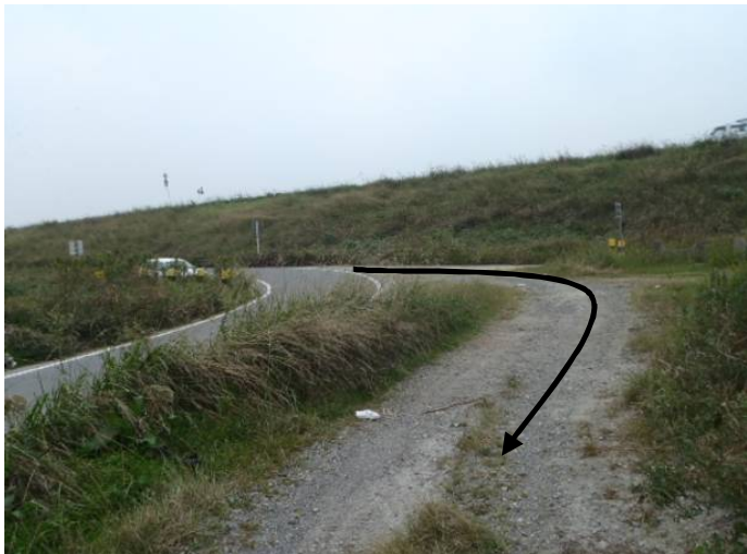
入口（高瀬橋北詰）の状況
