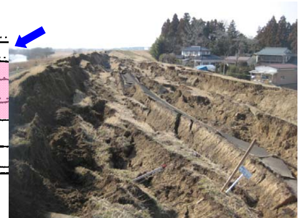
河川堤防の液状化の事例(鳴瀬川) 東北地方太平洋沖地震(2011.3)
