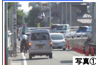
生活道路における離合が困難 (県道点喰新浜線)
