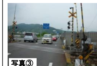
踏切事故が懸念 (県道鮎喰新浜線)
