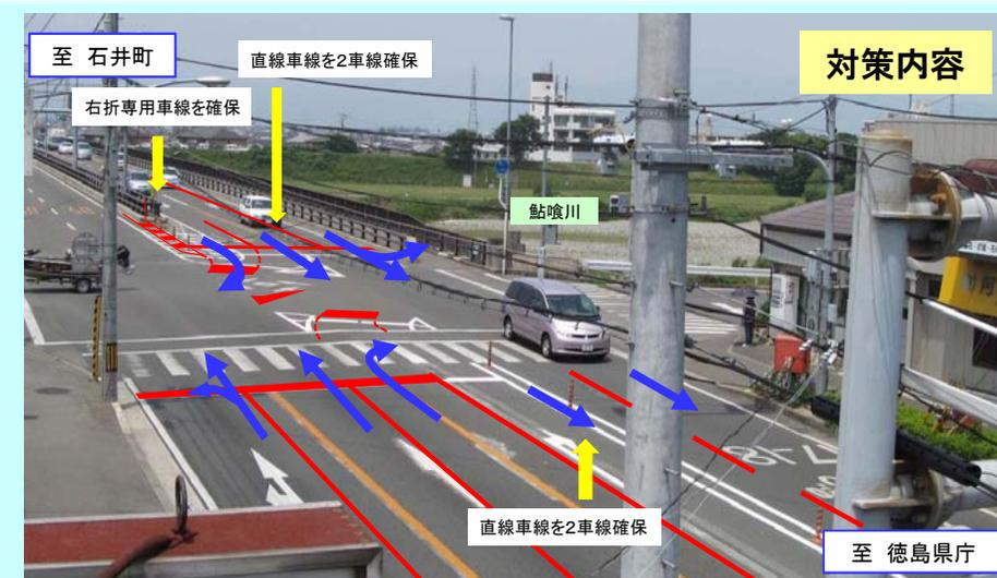
**平成24年6月8日（予定）からの工事で東向き直進車線2車線を設置し、15日（予定）に交差点改良が完成します。**
