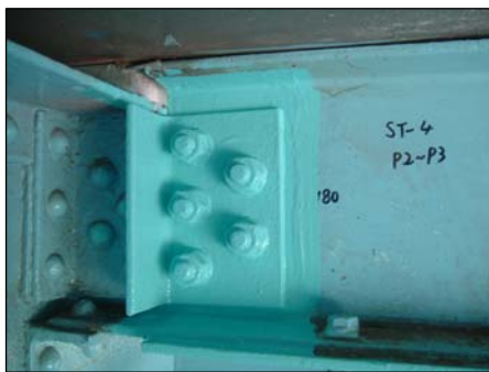
補強板取付の例
