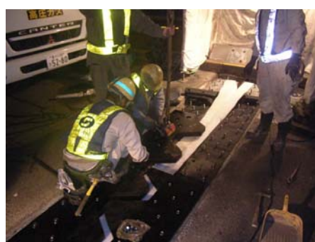
伸縮装置取替の例
