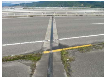
伸縮装置の破損
