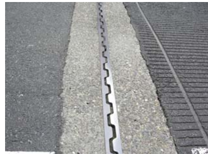
伸縮装置の損傷
