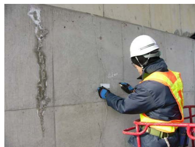
目視によるひび割れ点検
