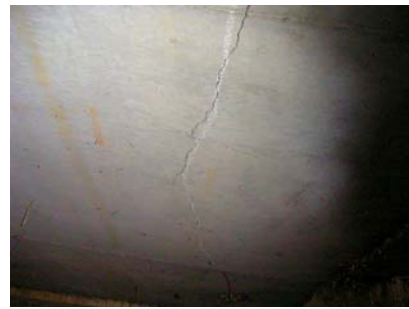
コンクリートのひび割れ
