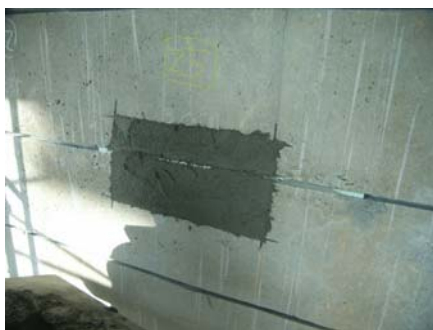
断面補修の例
