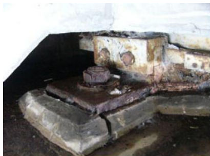
沓座モルタルの損傷
