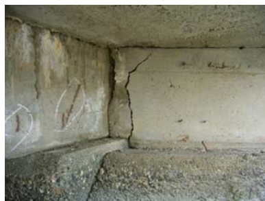
コンクリートのひび割れ
