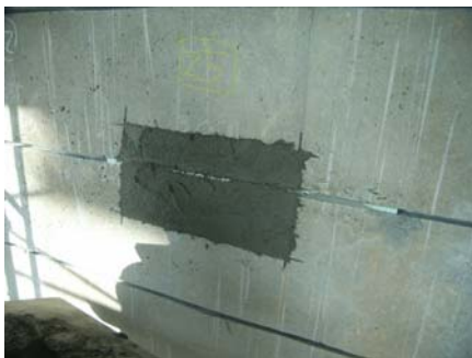
断面補修の例
