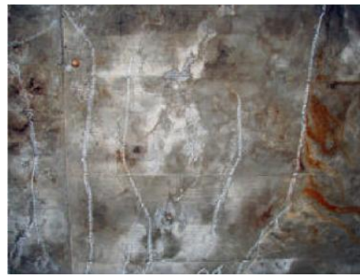
コンクリートのひび割れ
