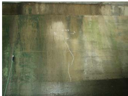
コンクリートのひび割れ
