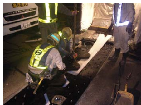
伸縮装置取替の例
