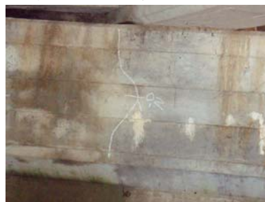
コンクリートのひび割れ
