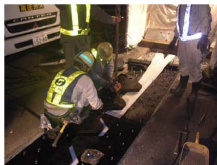
伸縮装置取替の例
