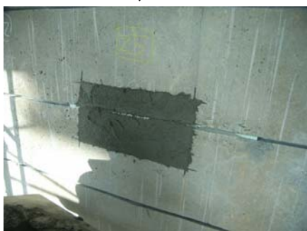
断面補修の例
