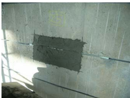
断面補修の例
