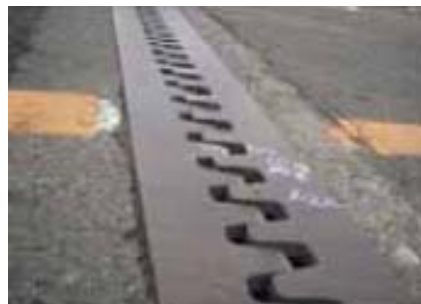
伸縮装置の破損
