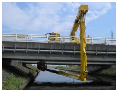
橋梁点検車による定期点検
