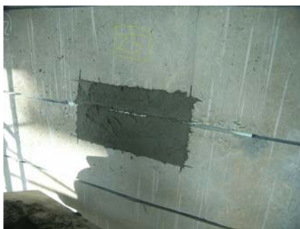
断面補修の例
