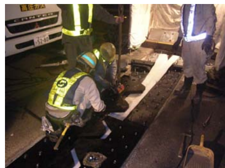
伸縮装置取替の例
