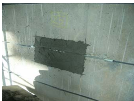
断面補修の例
