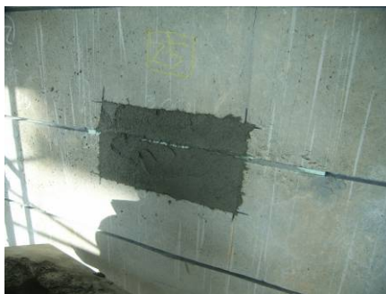
断面補修の例
