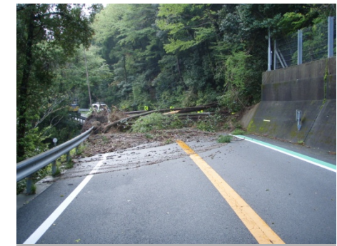
被災状況(H22.4)
