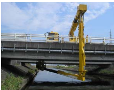
橋梁点検車による定期点検
