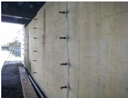
ひび割れ注入の例
