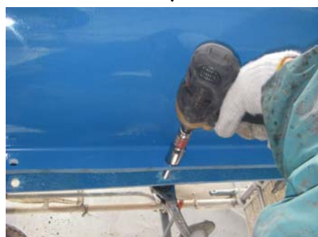
ナット増し締めの例
