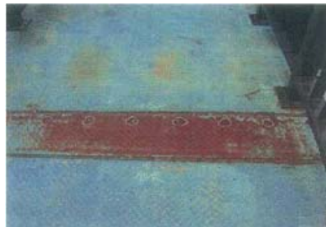
ナットのゆるみ・脱落
