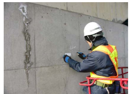
目視によるひび割れ点検
