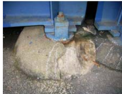
沓座モルタル損傷(アンカーボルトゆるみ)
