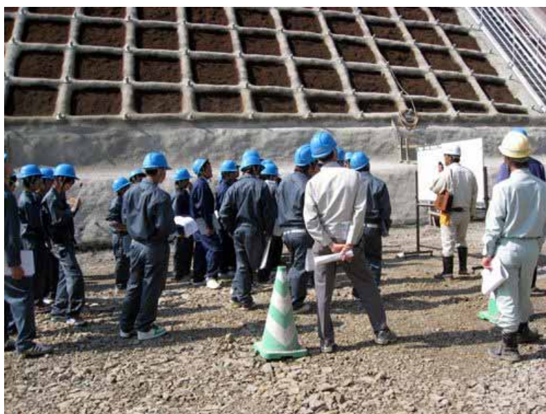
貞光工業高等学校による改良工事現場見学 (H21.10.28 三好市池田町にて)
