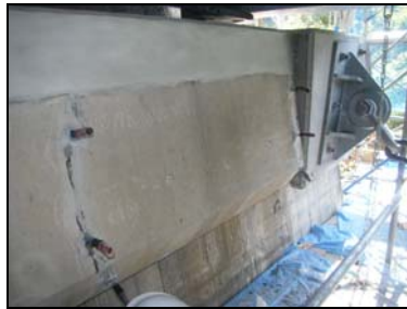
ひび割れ注入の例
