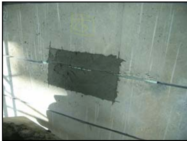
断面補修の例
