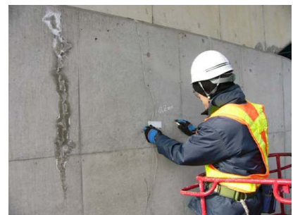
目視によるひび割れ点検
