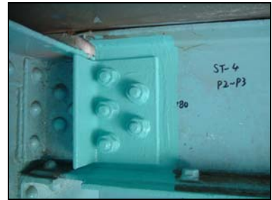
補強板取付の例
