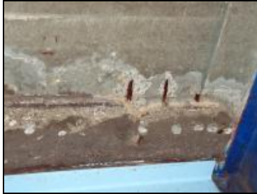
剥離・鉄筋露出
