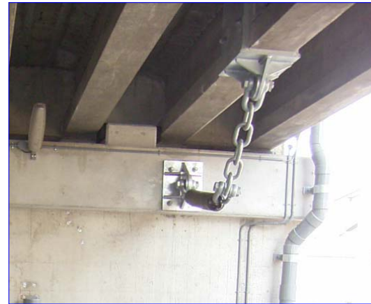
落橋防止装置取付例 2
