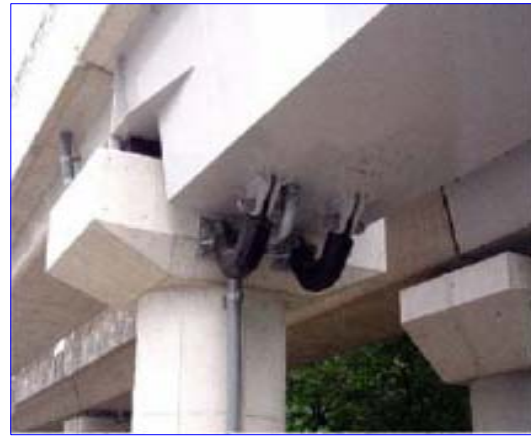
落橋防止装置取付例 1
