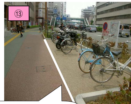
区画線で外枠を明示
