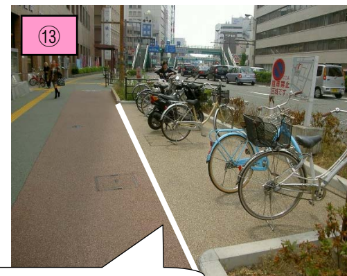
区画線で外枠を明示
