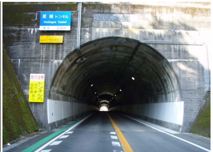
トンネル区間でのグリーンライン、トンネル内装塗装の実施状況
