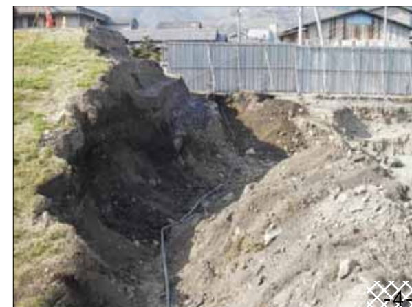
【開削箇所西側の道路下の埋設管】
