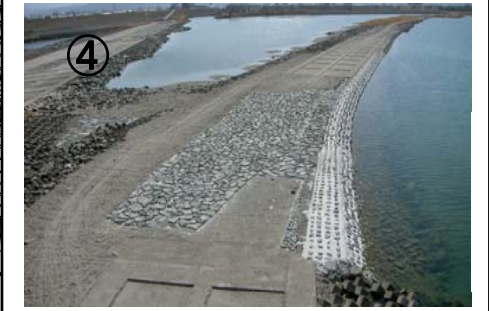
H18施工箇所(完成写真)
