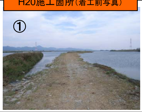
H20施工箇所(着工前写真)
