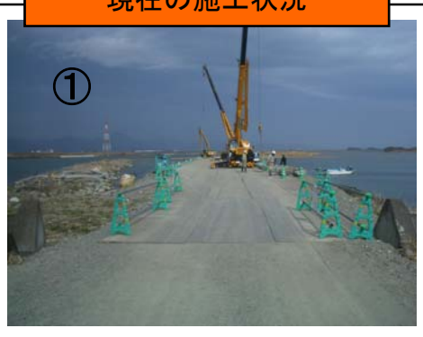
現在の施工状況
