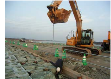
⑤石張り施工状況
