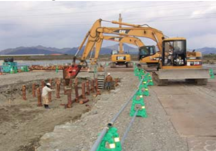
③杭木設置
