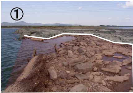
H19.11下旬の施工状況
