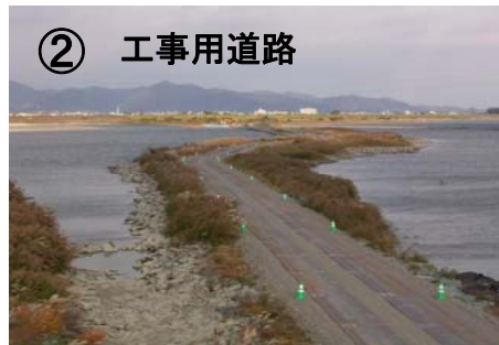
現在の施工状況
