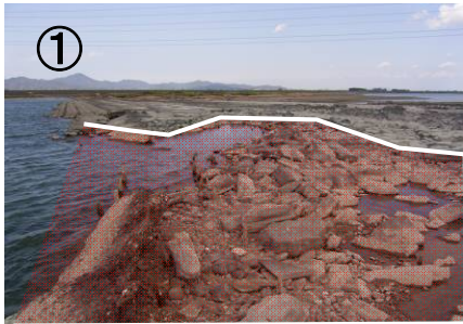
H19施工箇所(着工前写真)
