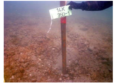
固定杭設置状況写真
