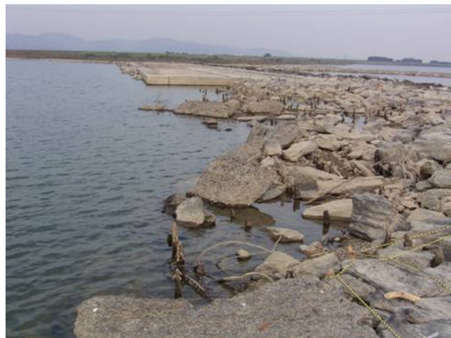
H18施工箇所 (着工前写真)
