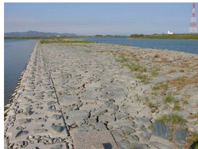
H17施工箇所 (完成写真)
