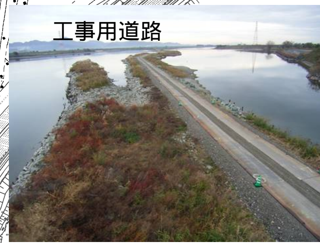
現在の施工状況の写真
