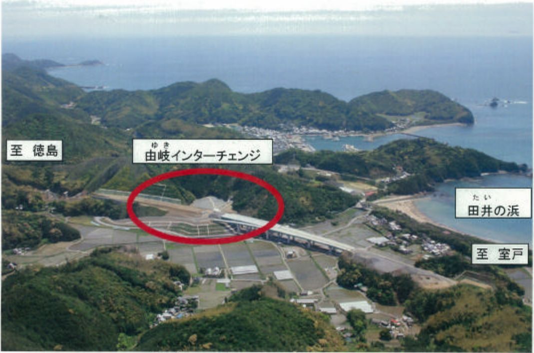
ゆき 由岐インターチェンジ現況
