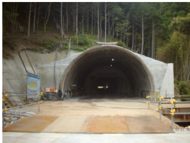
北白浜トンネル(仮称) 坑口
