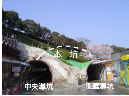
法花トンネル終点側坑口
