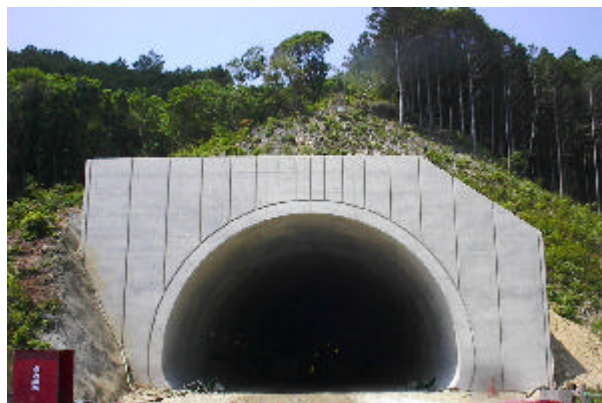
木岐第1トンネル坑口
