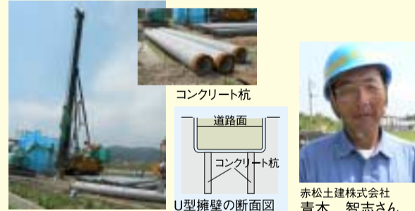
コンクリート杭打機
