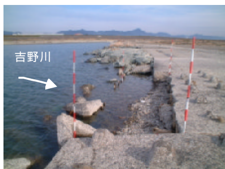
箇所 下堰平張コンクリート及びコンクリートブロック流失箇所
