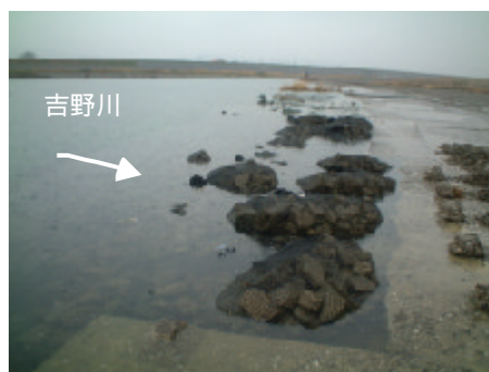
箇所 下堰平張コンクリート及びコンクリートブロック流失箇所
