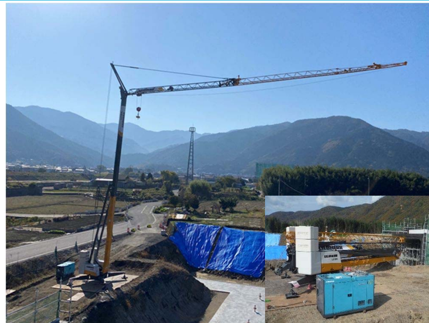
施工現場の全景 (古川樋門)
